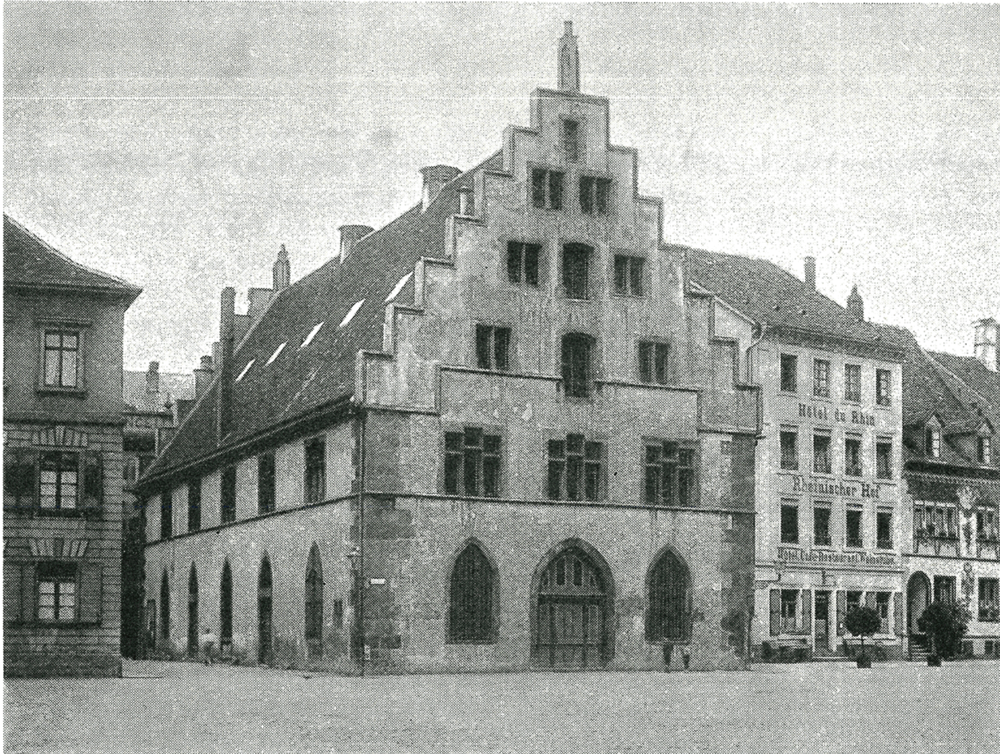
Das Kornhaus mit dem typischen Treppengiebel Die Tür- und Fensteröffnungen im Erdgeschoß stammen aus dem Jahr 1823
