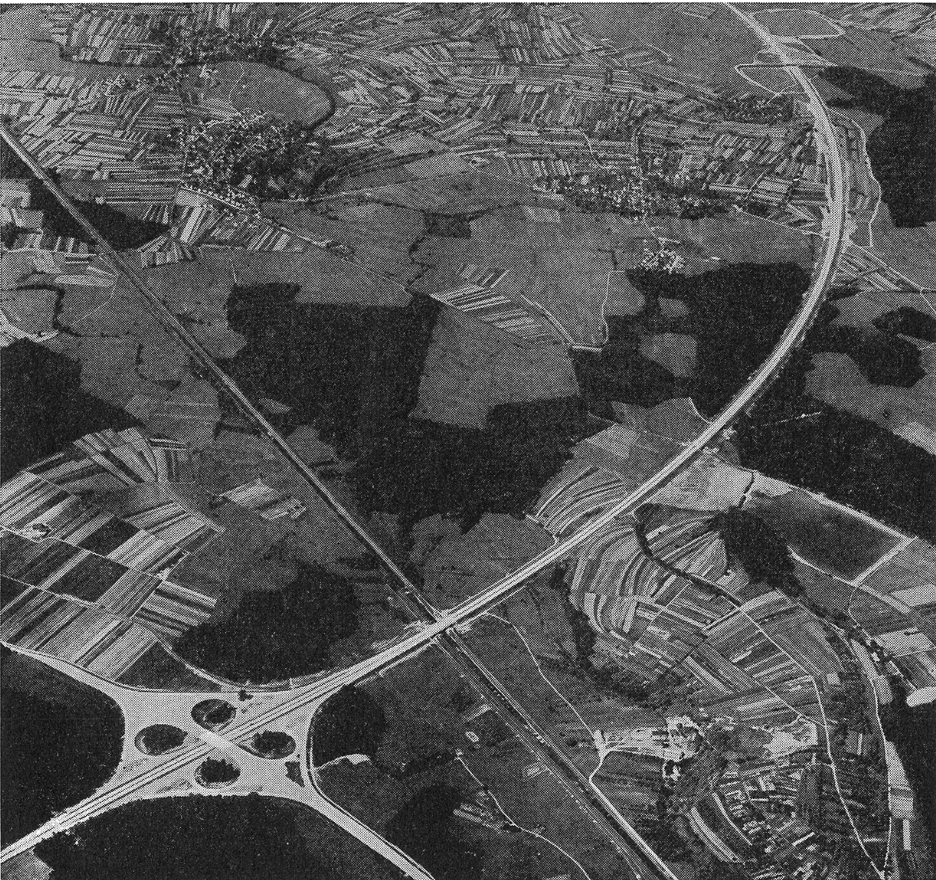
Das „Freiburger Kreuz“ an der Autobahn Karlsruhe — Basel im Bau (Ende 1962)
