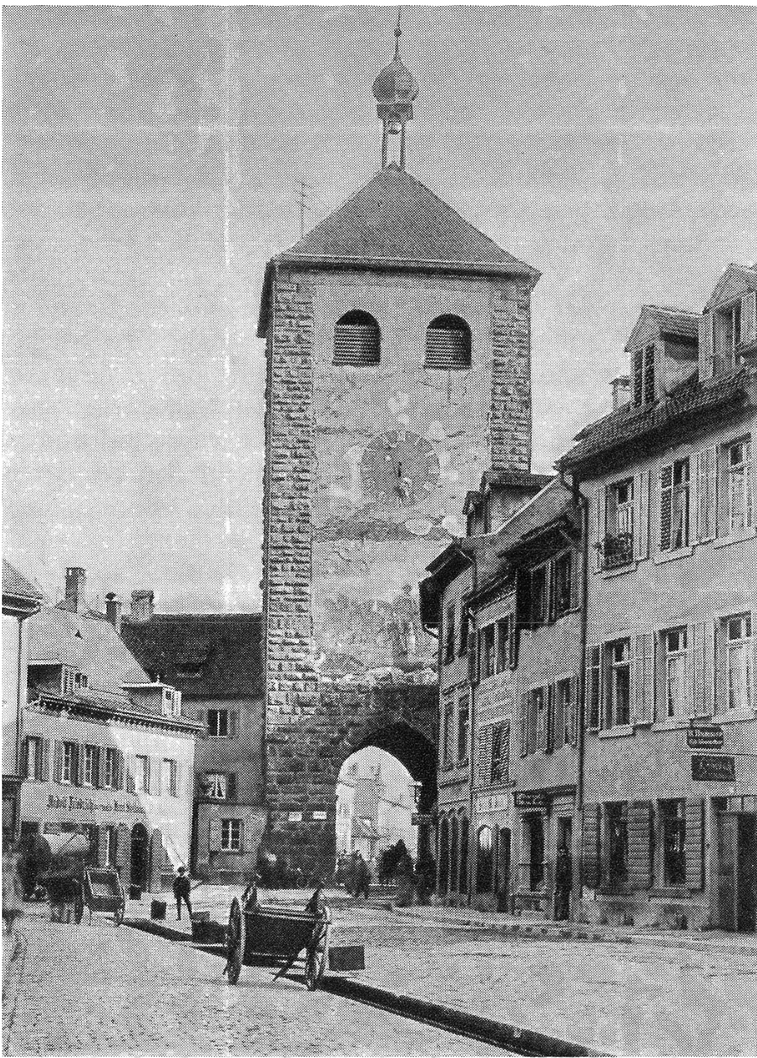
Das Schwabentor vor der Aufstockung im Jahre 1901
